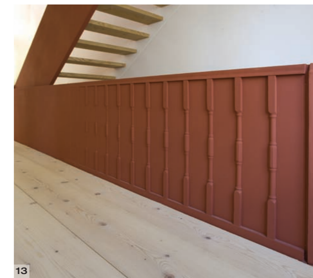
13 Das historische Treppengeländer wurde zerlegt und restauriert. Ein Test zeigte, dass der ursprüngliche Anstrich aus roter Temperafarbe bestand. Diese schmückt auch jetzt die gesamte Konstruktion. Die Form des alten Geländers verliert sich allmählich durch immer schwächer werdende Ausfräsungen in einer glatten Fläche.
