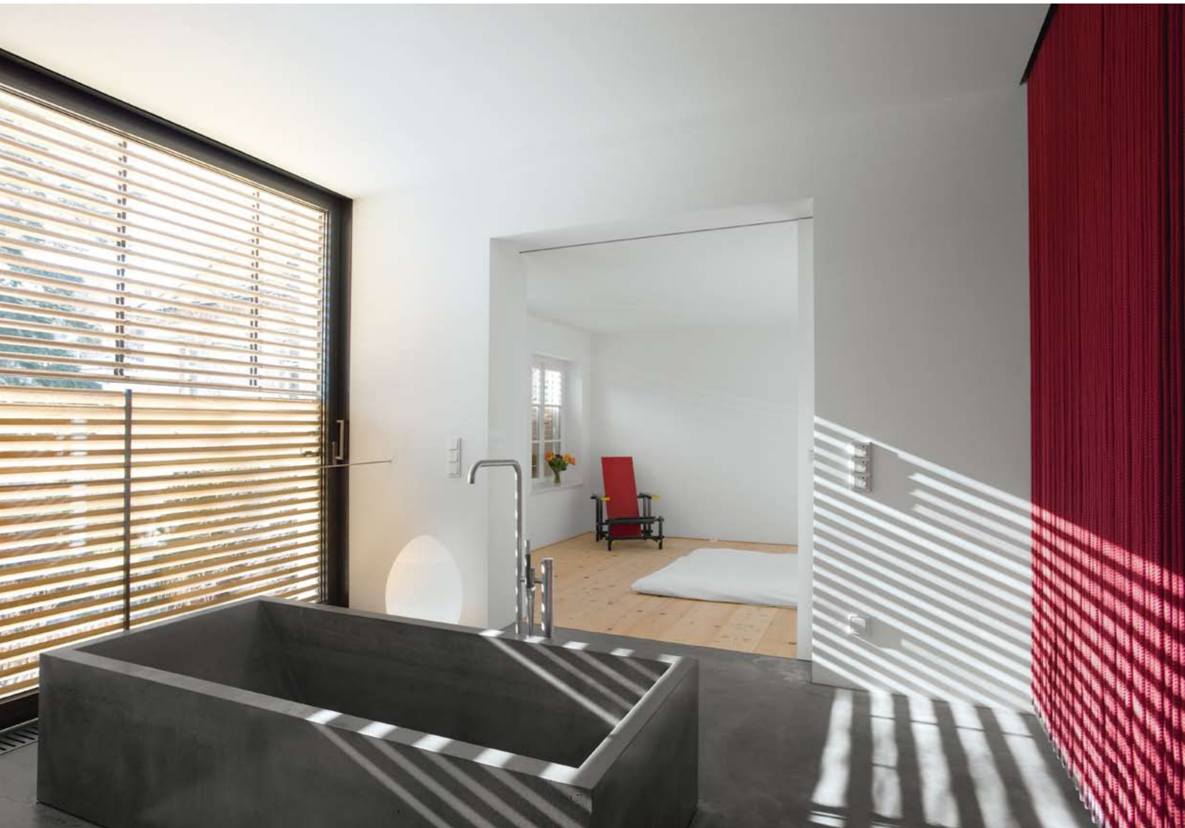
Im ersten Stock des neuen Zwischenbaus befindet sich der Masterbathroom mit raumhoher Verglasung und Sichtschutz aus Holzlamellen.
