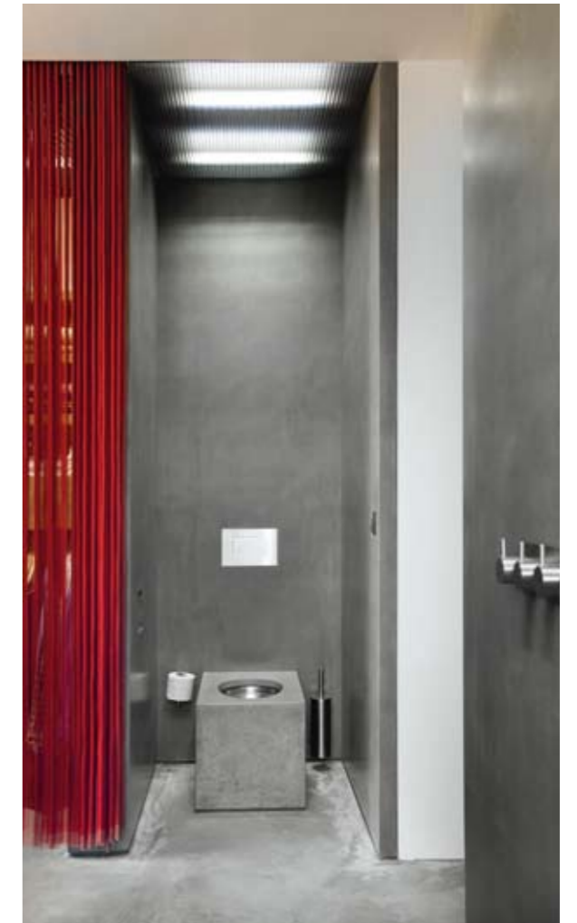
Alle Einrichtungsgegenstände der Bäder des Hauses wurden nach Entwürfen der Architekten und in enger Absprache mit den Bauherren von der Freiburger Manufaktur Villa Rocca aus gefärbten Beton gefertigt. Glanzpunkte setzen die Armaturen und Accessoires von Vola im klassisch-modernen, dänischen Design. Der speziell gefertigte Vorhang aus rot eingefärbten Hanfseilen trennt WC und Ankleide optisch vom Bad ab.
